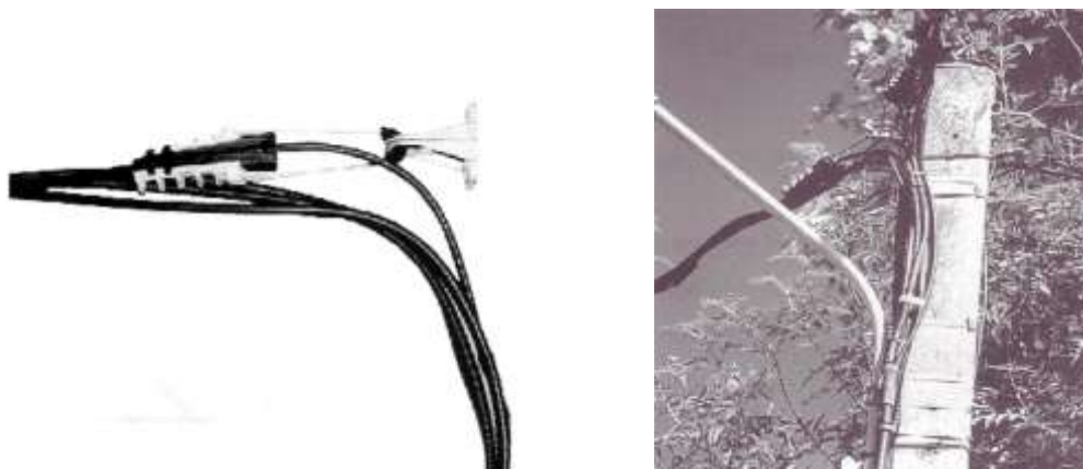
Fig.31. Montare clemă de întindere pană
