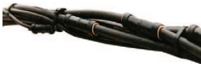
Fig.23. Înădirea conductoarelor dintr-un fascicol torsadat
